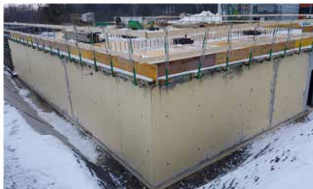
Otvoreni iskop sa SikaProof® A+: nakon skidanja oplate, distanceri oplate moraju biti zabrtvljeni.
