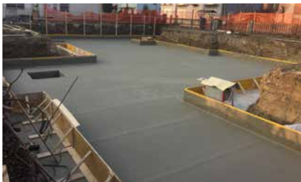
Tipična primjena SikaProof® A+ sustava na temeljnoj ploči.
