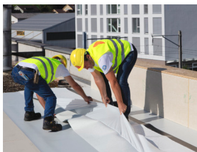
1. Uklonite Sarnafil® AT FSA P zaštitu
