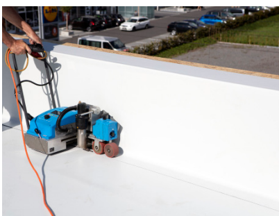
5. Završno zavarivanje vrućim zrakom
