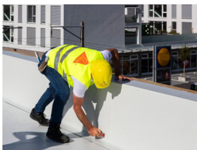
4. Pritisnite membranu pomoću odgovarajućeg valjka
