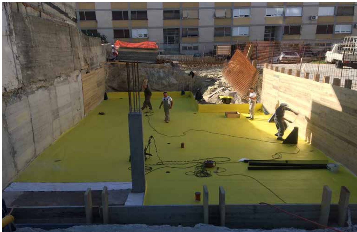
Lijevo: Studentski kampus u Varaždinu - kazetni sustav temeljne hidroizolacije uz Sikaplan® WP 1100-HL Iznad: postavljanje Sikaplan® WP 1100-HL hidroizolacijske membrane na temelje privatne kuće u Splitu
