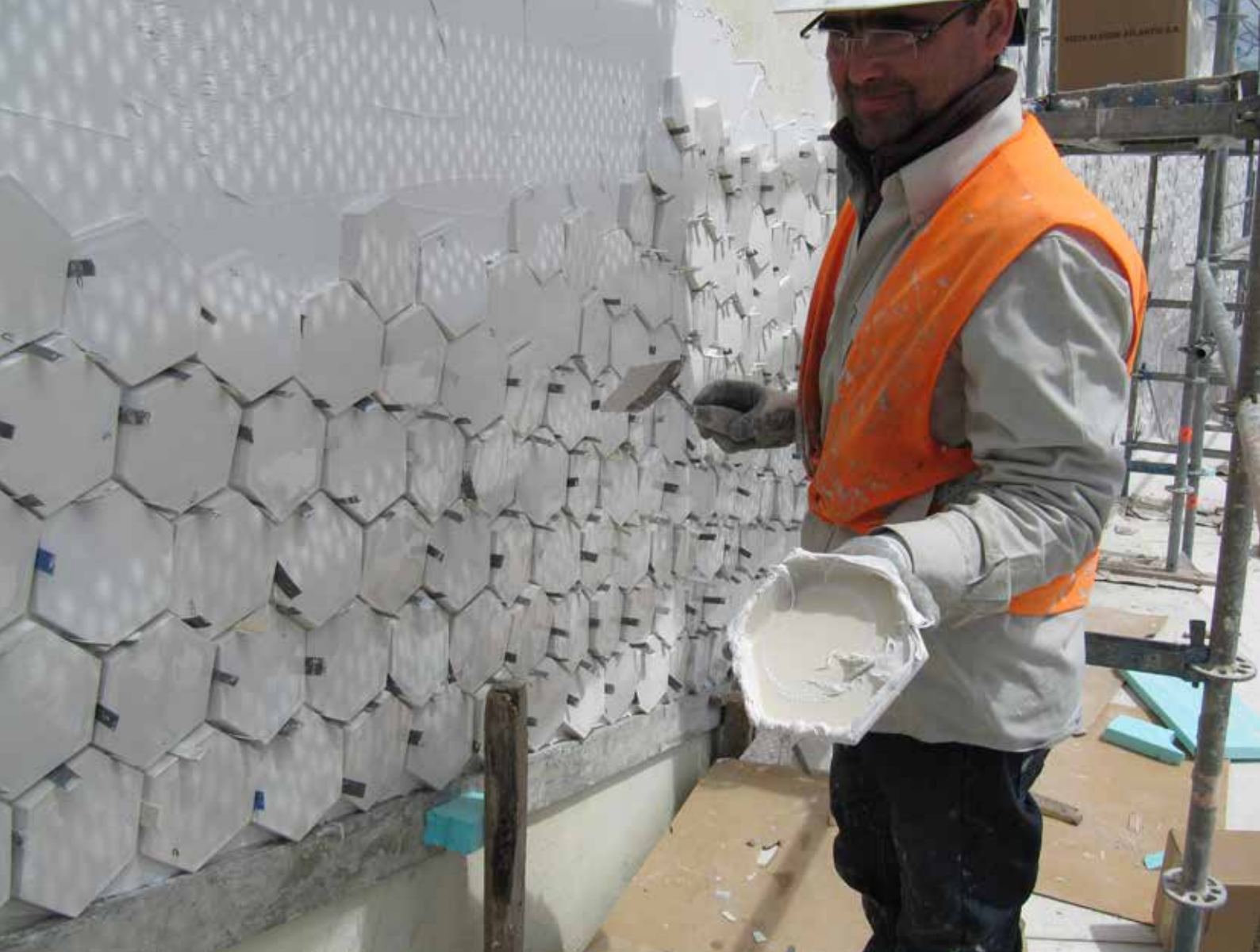
Zbog otežanog pristupa na vertikalnim površinama, keramičari su u jednom danu mogli položiti samo 5 m 2 po osobi.
