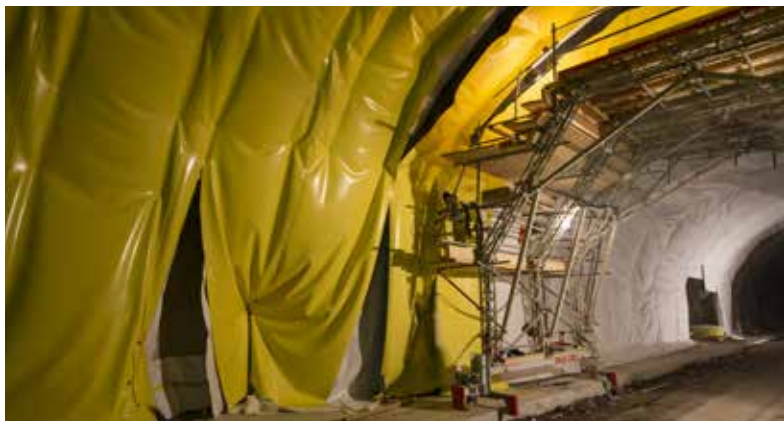
U širenju tunela Klaus u Gornjoj Austriji upotrijebljeno je 120 000 m 2 Sikaplan® sustava za hidroizolaciju, protiv propuštanja i izbijanja vode i vlage.
