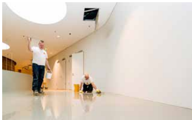
KORAK 4. Širok izbor tekućih materijala na bazi smole dostupan je u gotovo neograničenoj količini boja i za brojne namjene. Dekorativni listići ili protuklizni agregati mogu se dodati na mokru površinu.
