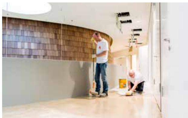
KORAK 2. Nanosi se tekući premaz kako bi se dobra veza s podlogom, što se obično vrši lopaticom i valjkom. Odgovarajuća metoda može se odabrati ovisno o kvaliteti podloge.
