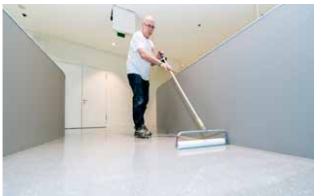
KORAK 5. Završni dodir je primjena prozirnog ili pigmentiranog premaza, a ovaj korak obično uključuje valjak ili špricu. Završni premaz osigurava željeni konačni dizajn i dodaje kvalitetu otpornosti na trenje i habanje.
