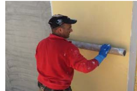
4) Press the membrane firmly
