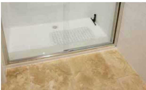
Hidroizolacija vlažnih prostora kao što su kuhinje, kupaoalice...
