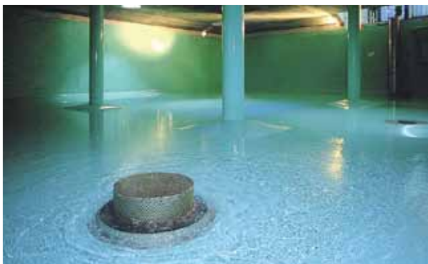
Hidroizolacija spremnika pitke vode
