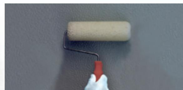
Ugradnja tiksotropnog premaza sa strukturiranim valjkom
