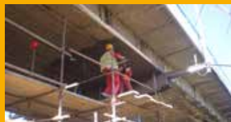
SANACIJA I ZAŠTITA
