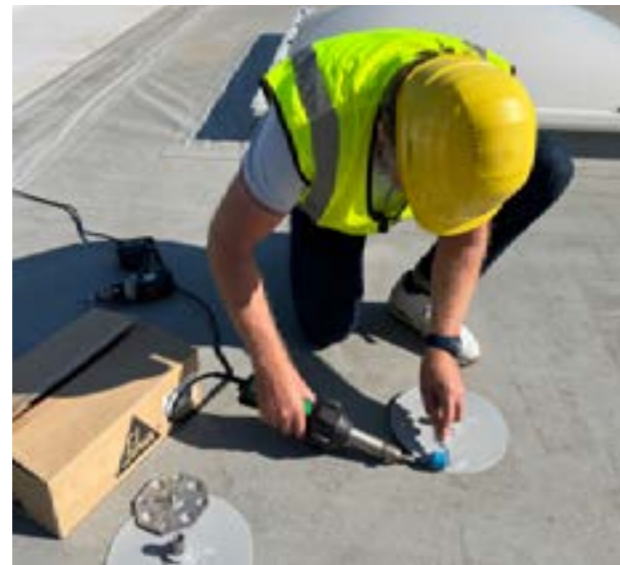
SikaRoof® Sidro 250 mm CR pričvršćeno na SikaRoof® Sidro Podložak 140 mm i spojeno na hidroizolacijski sloj krova putem vrućeg zraka.
