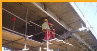
SANACIJA I ZAŠTITA
