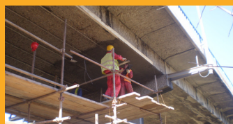
SANACIJA I ZAŠTITA
