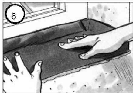
Membrana se može naknadno prilagoditi u periodu od 30 min. po montaži iste.
