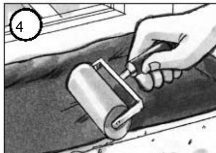
Uz pomoć plastičnog valjka, lagano pritisnuti **SikaMembran** traku. Membrana mora biti u potpunosti zalijepljena po cijeloj širini od minimalno 4 cm.
