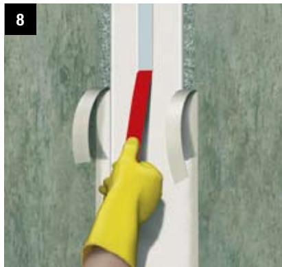
Maknuti maskirnu traku s rubova spojeva i crvenu srednju traku radi postizanja preciznog detalja.
