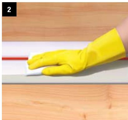
U slučaju zaprljanja očistiti **Sikadur-Combiflex® SG** traku suhom ili mokrom krpom. Ne koristiti otapala već isključivo vodu.
