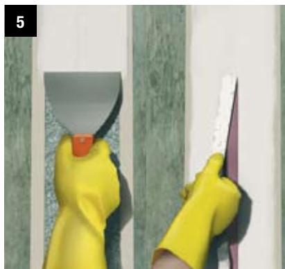
Nanijeti **Sikadur®-Combiflex® CF** ljepilo na lijevu i desnu stranu spoja. Potom skinuti traku za prekrivanje spoja.
