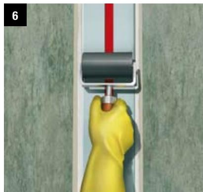
Utisnuti **Sikadur-Combiflex® SG** traku na poziciju i preći valjkom preko trake kako bi se istisnuli zarobljeni mjehurići zraka sve dok ljepilo sasvim ne izade van ispod trake ~5mm.
