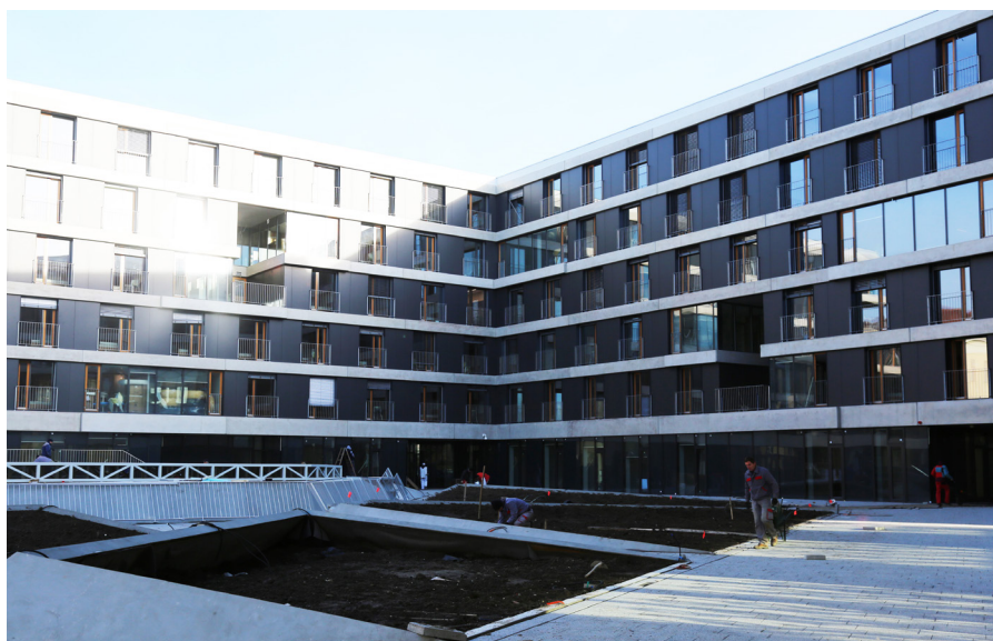
Novi dio kampusa u fazi izgradnje
