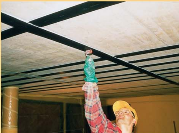
Ojačanje betonske ploče sa Sika® CarboDur® trakama i Sikadur® ljepilom.
