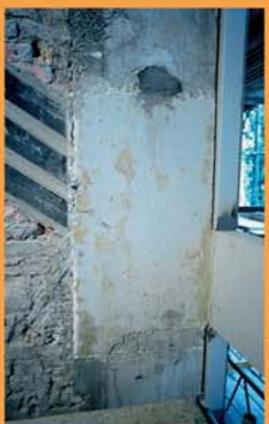
Udubljenja ispunjena epoksi mortom
