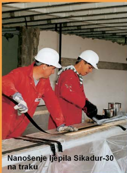
Jednostavna postava Sika CarboDur traka
