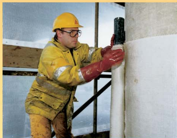
Ojačanje stupa mosta sa SikaWrap® tkaninom
