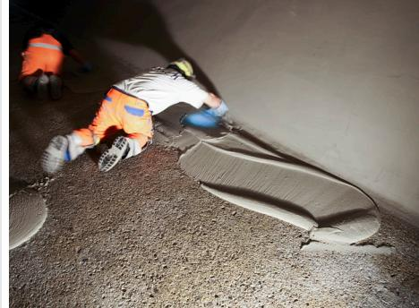
Postupak 7.4 Realkalizacija karboniziranog betona difuzijom
