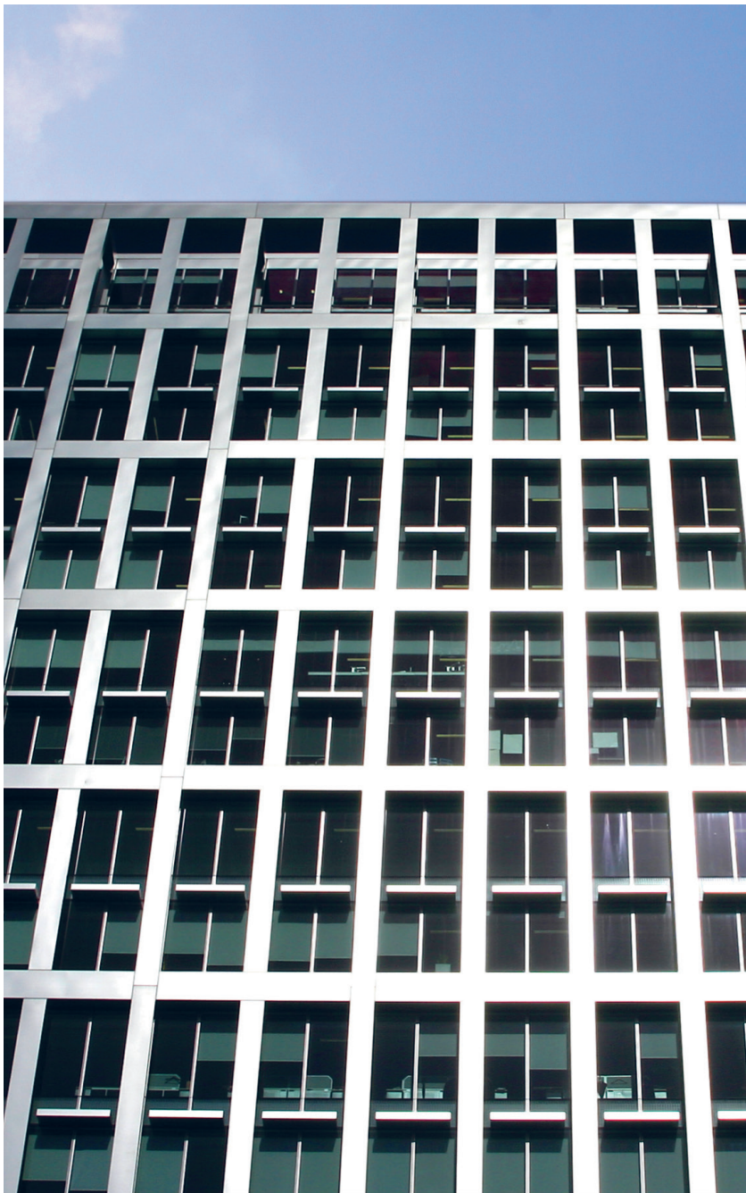
gore lijevo: 5 Aldermanbury Square, London, 2005. Arhitekt Eric Parry Architects; Izvođač Lindner-Schmidlin UK
