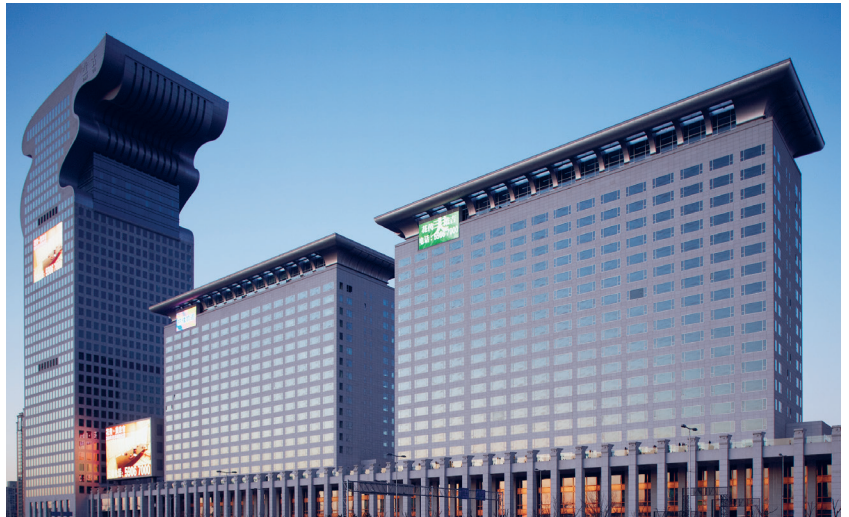
dolje: CNOOC Building, Beijing, 2005. Arhitekti Kohn Pedersen Fox Associates PC; Izvođač Josef Gartner
