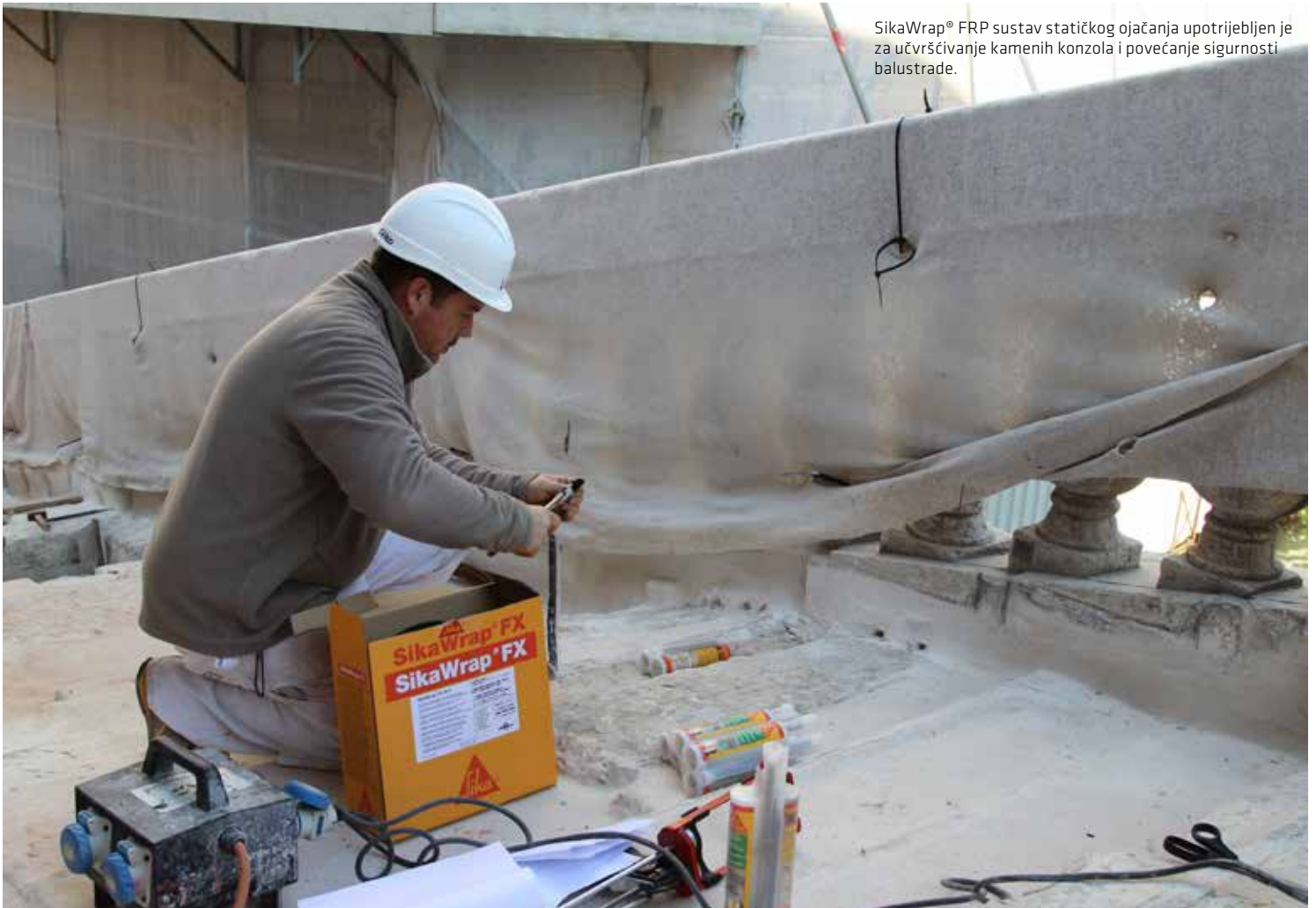
Cjelokupno rješenje za ojačanje je u potpunosti neinvazivno i nevidljivo, skriveno ispod glavne ploče.
