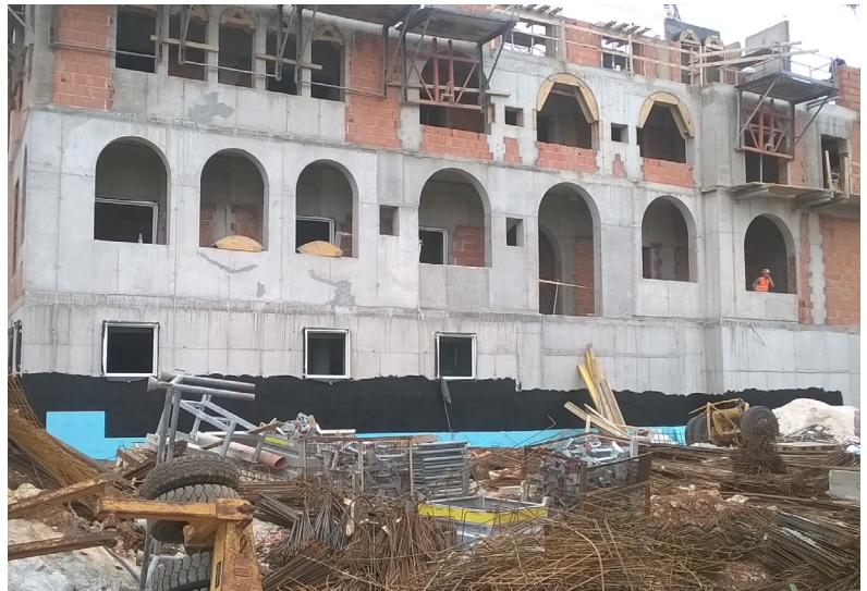
Spojevi temeljne konstrukcije osigurani su Sika® Dilatec® trakama na prijelazima hidroizolacijske membrane s jedne strane na beton s druge strane, što će spriječiti neželjene prodore vode i vlage, a trake su zalijepljene pomoću Sikadur®-31 FC Rapid Ijepila s izuzetno kratkim vremenom stvrdnjavanja.
