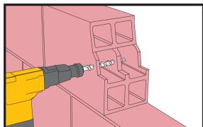
Izbušite rupu električnom bušilicom do potrebnog promjera i dubine. Promjer rupe za bušenje mora biti u skladu s veličinom sidrenih i perforiranih tipli. Napomena: sa šupljim materijalom ne koristite rotacijske čekićaste bušilice.
