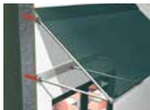
Sidrenje raznih elemenata
