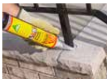
Kod sanacija raznih sidrenih elemenata.
