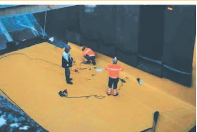
Hidroizolacija PVC membranama
