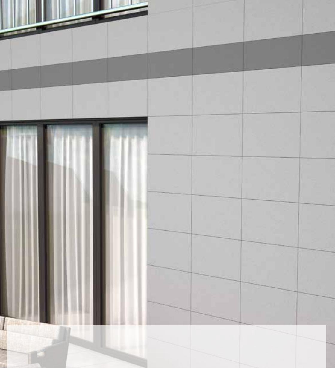
Postavljanje pločica na fasade dugo je smatrano izazovom i velikim rizikom. Međutim, Sika je razvila fleksibilna ljepljiva za pločice i popratne mase za fugiranje čija kombinacija može izdržati izloženost vrlo zahtjevnim kriterijima, uključujući ekstremne vremenske uvjete i promjene te toplinske karakteristike različitih fasadnih materijala.
