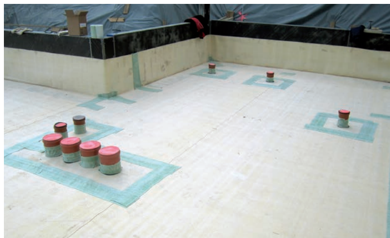
Završeni unutarnji detalji spajanja
