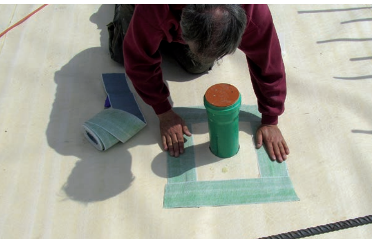
Unutarnji detalj spoja sa SikaProof® Tape -150
