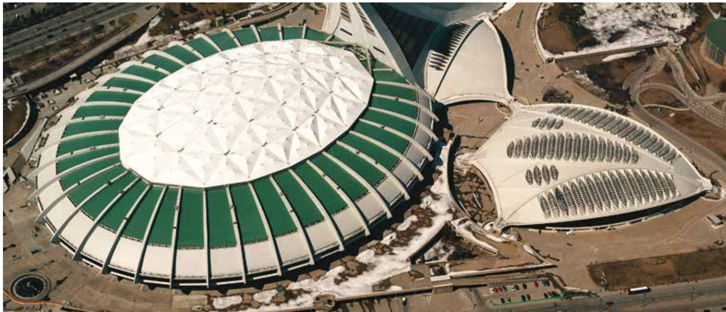
Krov Olimpijskog stadiona u Montrealu, zaštićen Sarnafil® hidroizolacijskom membranom.
