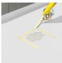
2. Trakom označiti (ograničiti) područje popravka (hidroizolacije)
