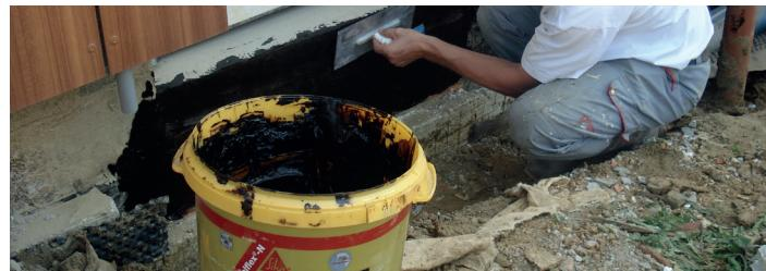
Hidroizolacijski premazi na bazi bitumena su jednostavni za ugradnju. Dodatna mogućnost kod ugradnje je u tome što se na njih direktno može lijepiti toplinska zaštita. Posebno su pogodni za ukopane zidove opterećene vlagom ili procjednom vodom.
