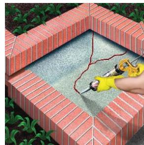
Za brtvljenje nepomičnih pukotina na betonskim dekama prije ugradnje bitumenske folije ili tekuće membrane.
