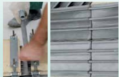
Spojevi između Sika® vodenih brtvi tipa AR/AF izvode se grijajućim bakrenim nožem dok su krajevi brtve pričvršćeni posebnim kopčama.
